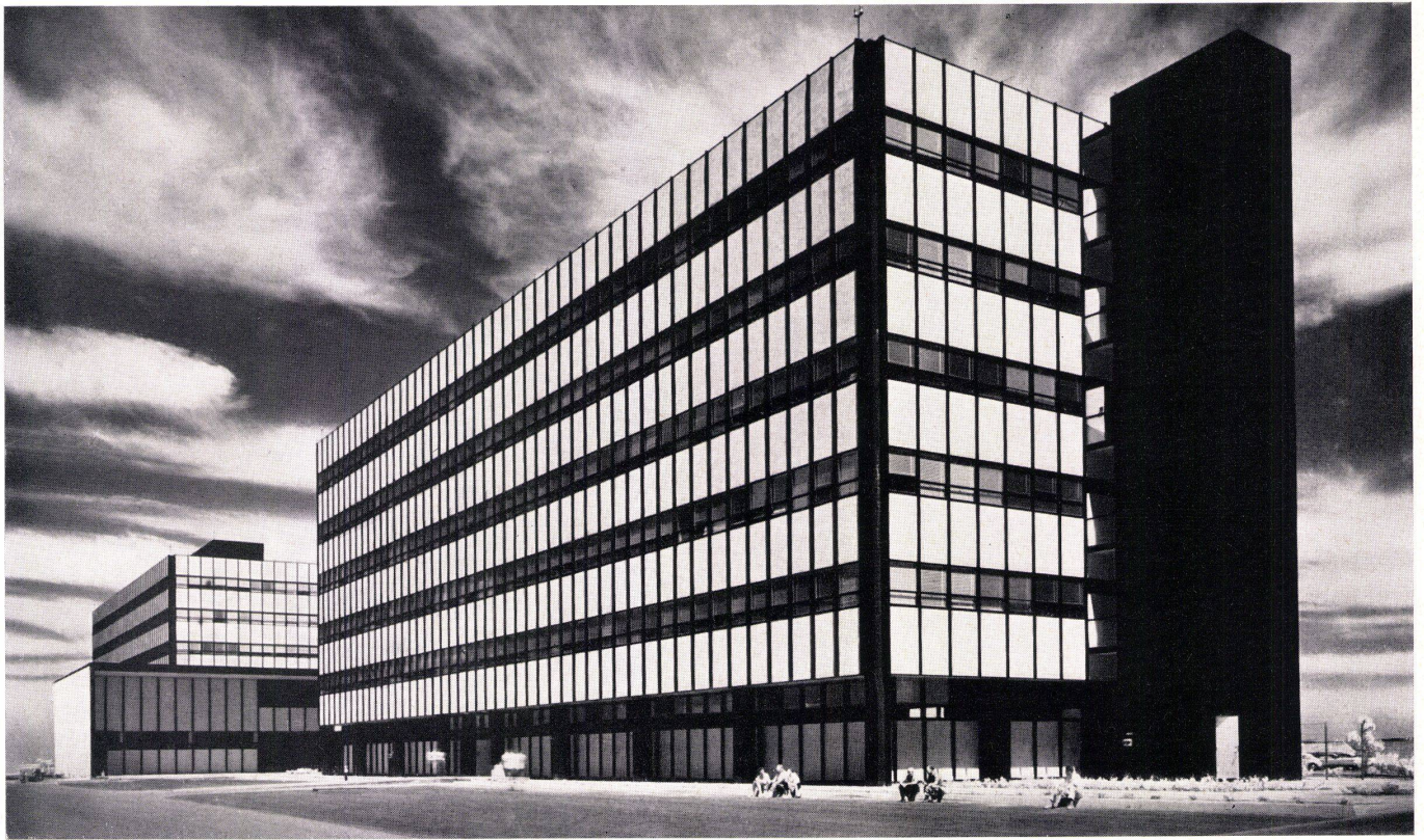
Verwaltungsgebäude. Bâtiment administratif. Administrative building.
