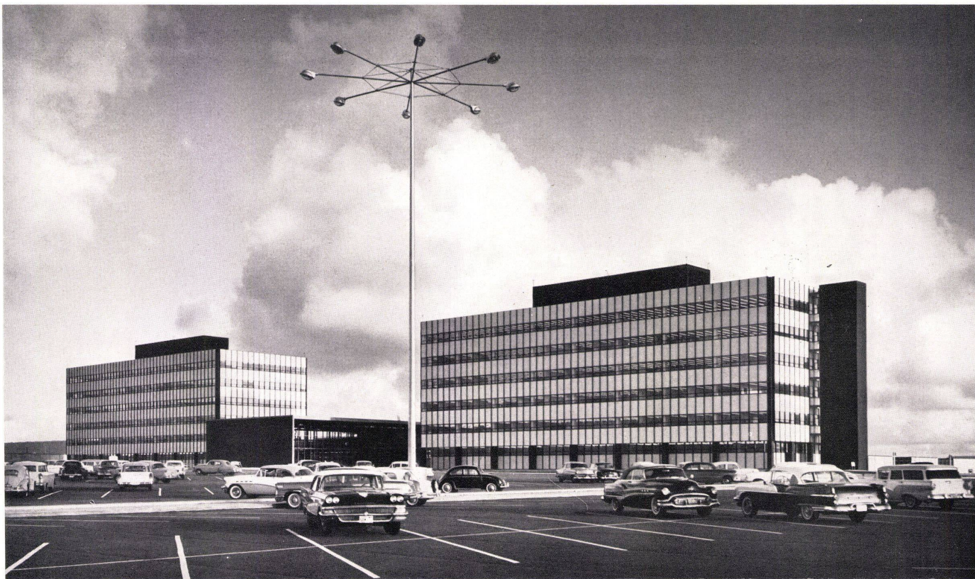
1 Ansicht von Nordwesten mit dem 2geschossigen Eingangsgebäude und den beiden 6geschossigen Bürohäusern.
