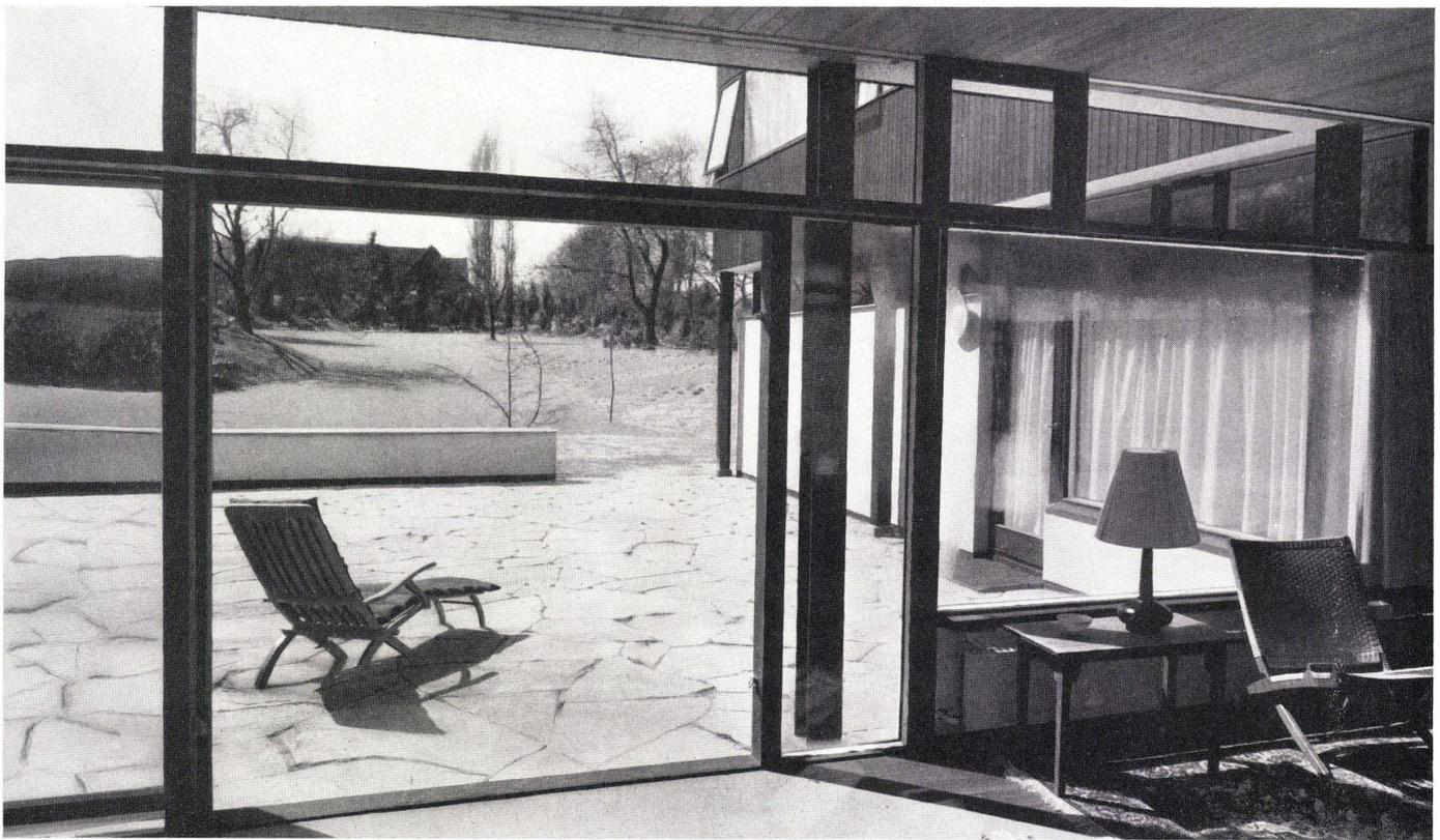
Blick vom Wohnzimmer auf den gegen Westen liegenden windgeschützten Sitzplatz. Die vor den Schiebefenstern und den Außenwänden stehenden Stahlstützen veranschaulichen das Konstruktionssystem.
