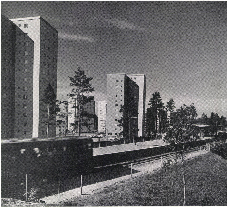
Vällingby Nachbarschaft Håsselbygård. Baugruppe am Vorortbahnhof Håsselby, Baujahr 1957.
