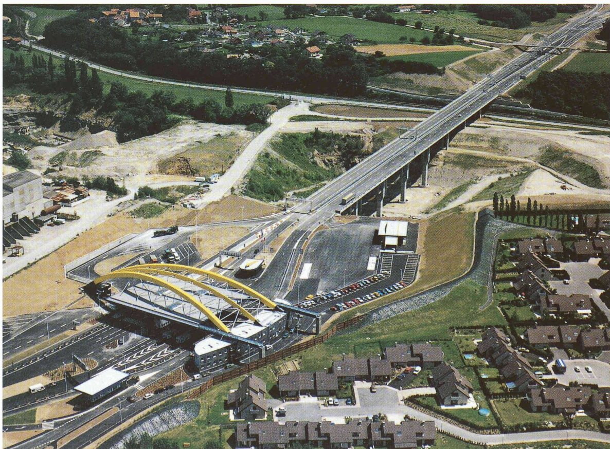
Fig. 5. - Plate-forme douanière française et viaduc de Bardonnex
