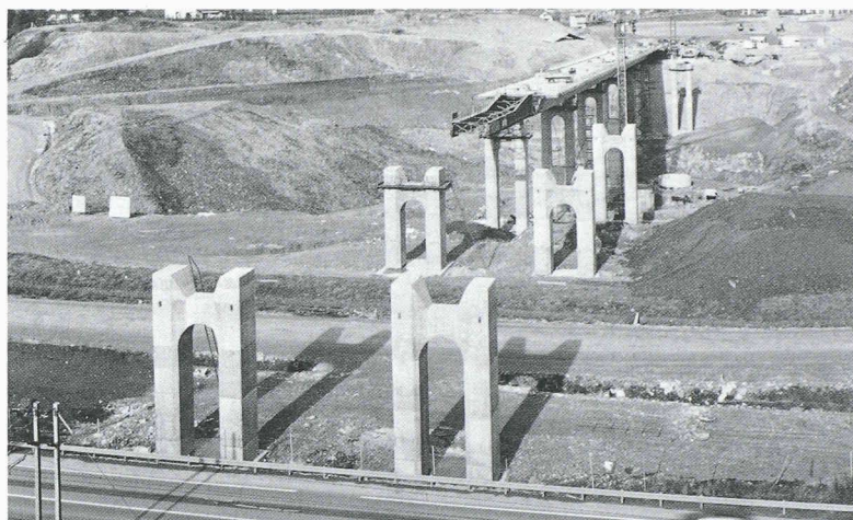
Fig. 3. – Viaduc de Bardonnex en construction
