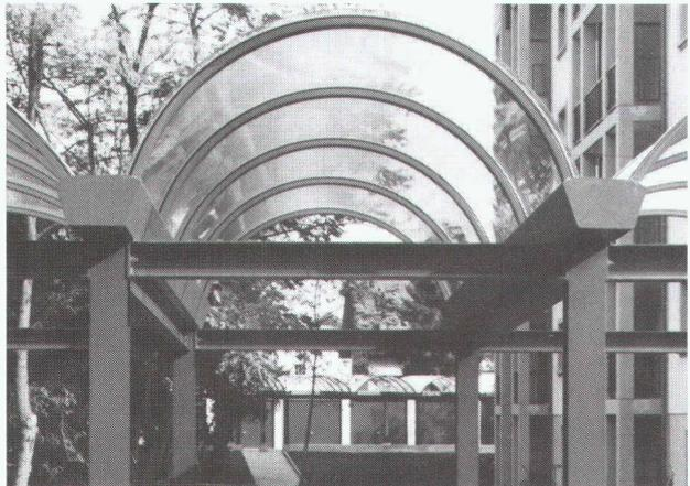
Claire ou fumée, telle se présente la solution légère et élégante pour la couverture de puits de lumière, d'entrées, d'abris, etc. Avec sous-construction et montage, directement d'usine. Variante en polycarbonate résistant aux chocs ou coupes en polyester (teintes à choix).
