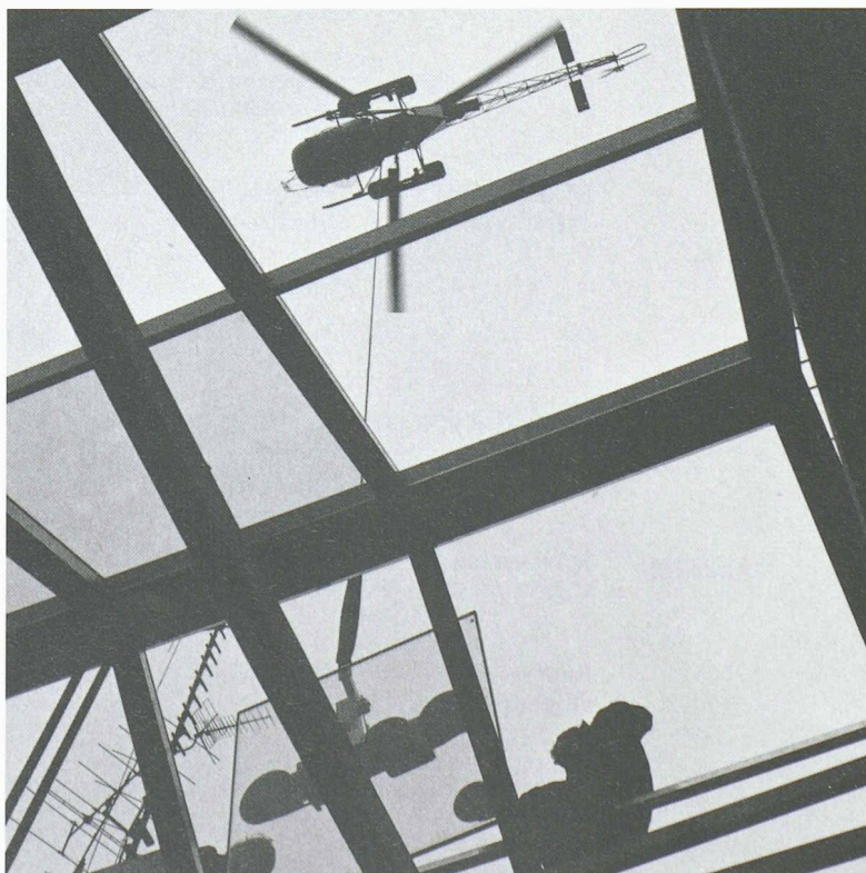
Maison SIA, à Zurich: montage de la verrière du patio construit sur le toit en 1991
