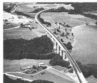
Viaduc du lac de la Gruyère sur la N12
