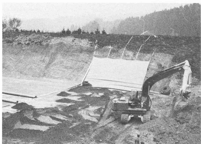
Fig. 4. — Après la pose des feuilles d'étanchéité synthétiques, tout en les remontant le long des talus, y compris la fixation suivante, une couche de sable de 20 cm d'épaisseur est mise en place avec des machines comme couche protectrice mécanique pour les feuilles de l'étanchéité. Les tas de sable éparés avant la pose de la couche de sable servent à charger les feuilles d'étanchéité synthétiques.
