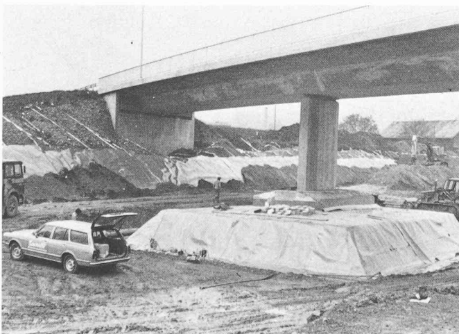
Fig. 3. — Seule la fondation d'un pont traversant la N1 perfore l'étanchéité. La feuille d'étanchéité synthétique d'une épaisseur de 2 mm a été raccordée hermétiquement à la fondation par un procédé développé par le fournisseur.
