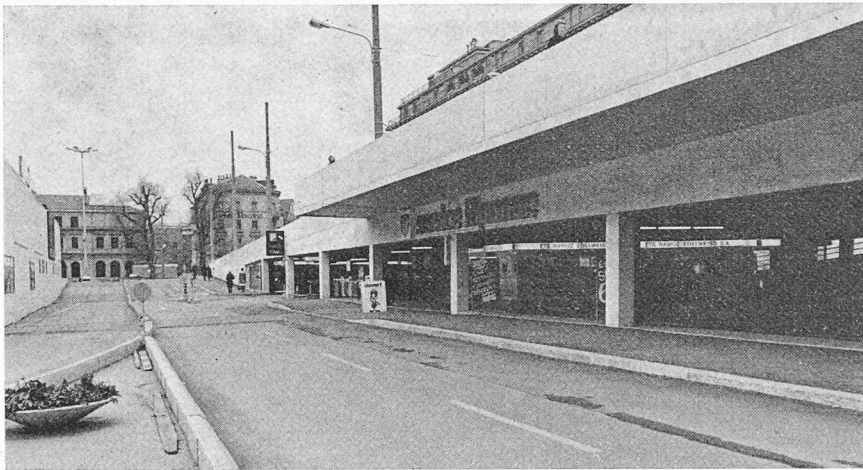
Fig. 29. — Lausanne. Place de la Riponne: le nouveau visage d'une place qui paie désormais lourdement son tribut à l'automobile.
