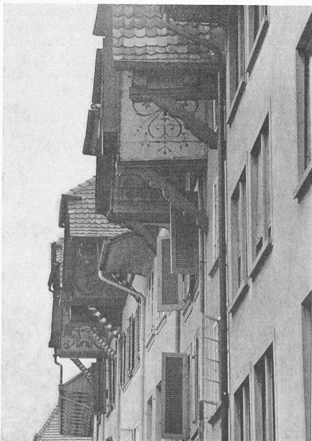
Fig. 53. — Aarau . Succession de « dômes » permettant de monter le bois au grenier.
