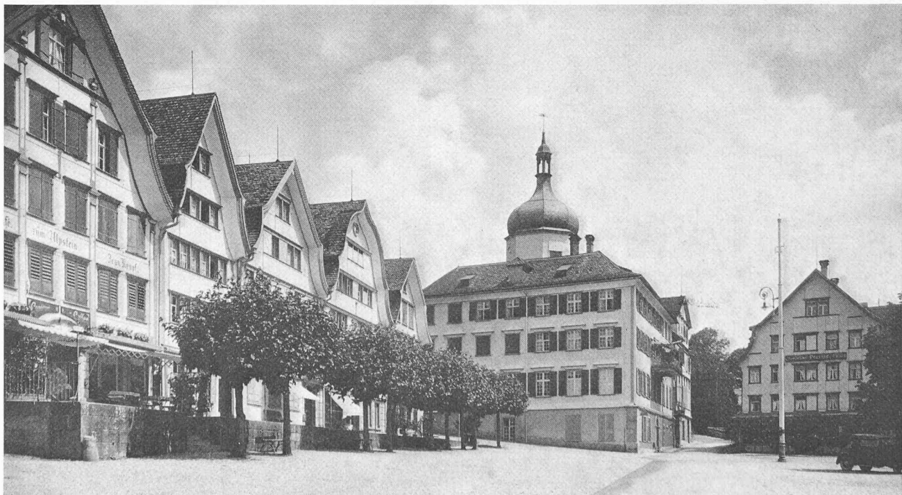
Fig. 50. — Gais. Groupe de pignons à forts avant-toits typiques du pays d'Appenzell.
