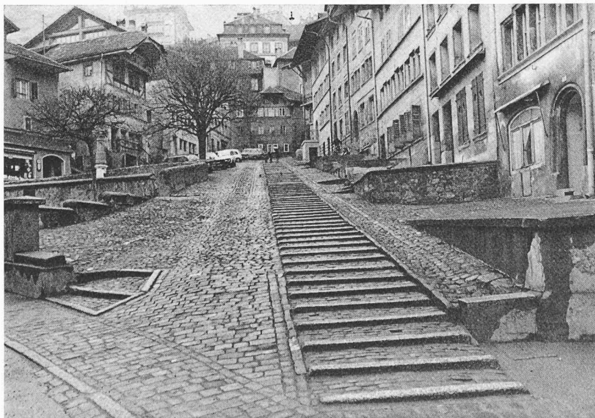
Fig. 62. — Fribourg . Quartier de la Planche: rien à changer à cet excellent témoin remarquablement conservé.
