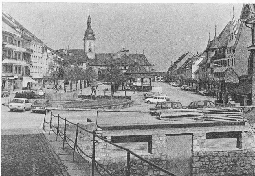
Fig. 33. — Bulle FR. Un cas où l'incendie n'a pas trop mal fait les choses. Sur le plan ci-contre, les parties non hachurées ont été détruites par le feu.
