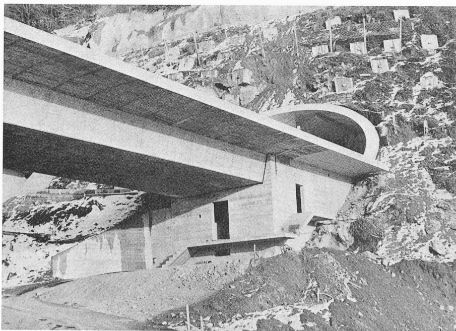
Fig. 4. — Culée évidée aménagée en bâtiment de service pour les tunnels du Flonzaley.
