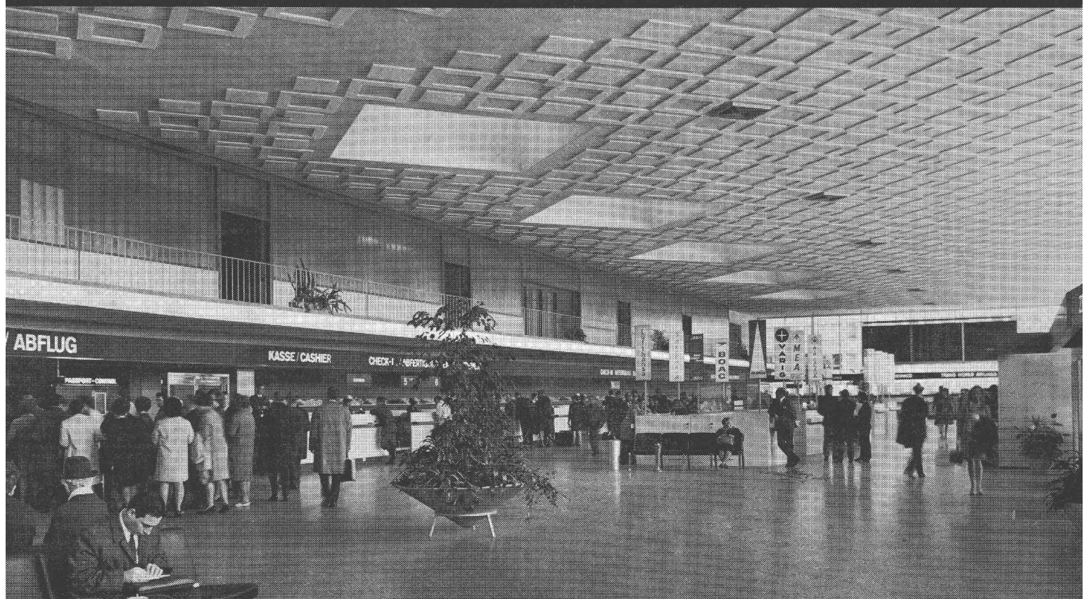
Aéroport de Zurich Hall des départs nord Direction des travaux : Flughafen-Immobilien-Gesellschaft, Zurich
