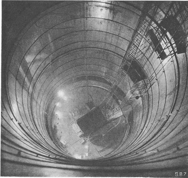
Fig. 12. — La chambre d'équilibre blindée à l'aide d'anneaux de 1,80 m, successivement posés par 4 sur 7,20 m de hauteur, puis soudés et bétonnés.
