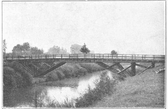
Fig. 8. — Vue du pont à arbalétriers achevé.
