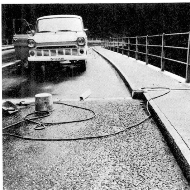
Fig. 5 Déplacement de culée
