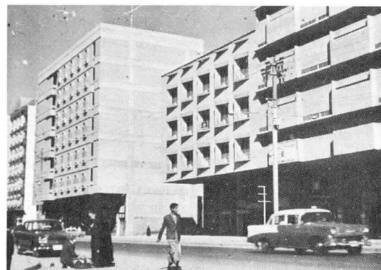
Bild 3: Strasse in Bagdad - Bürgersteigkragüberdachung
