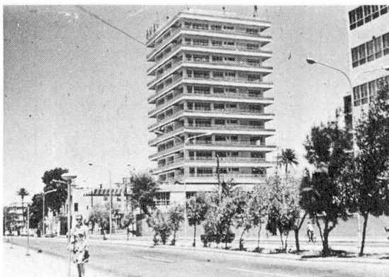
Bild 4: Stahlbetonskelettgebäude in Bagdad
