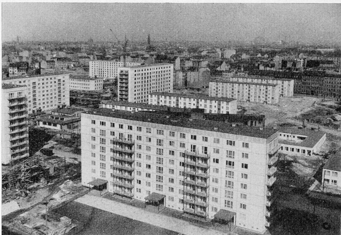
Bild 15 - Übersicht zur Montage von Wohngebäuden in Plattenbauweise (5000 kg max. Elementemasse). Im Stadtzentrum der Hauptstadt der DDR, Berlin. Montage mit Turmdrehkran 100 Mpm - Lastmoment.
