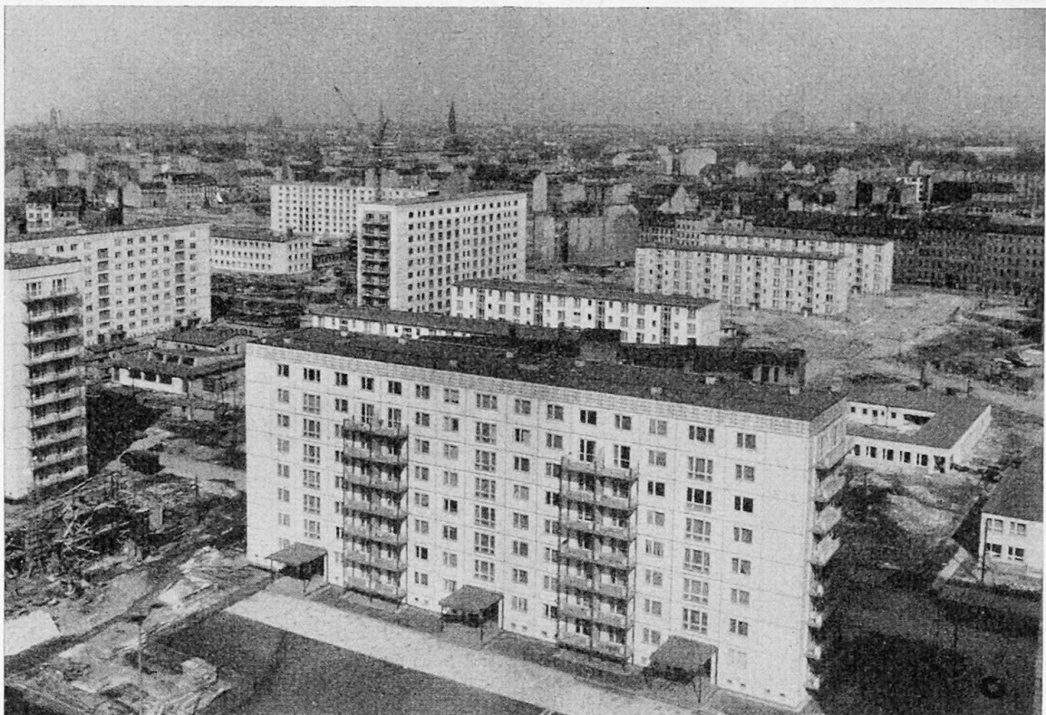
Bild 15 - Übersicht zur Montage von Wohngebäuden in Plattenbauweise (5000 kg max. Elementemasse). Im Stadtzentrum der Hauptstadt der DDR, Berlin. Montage mit Turmdrehkran 100 Mpm - Lastmoment.
