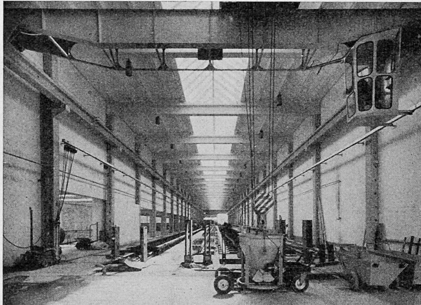
Abb. 3 - Spannbetonwerk in Avenches, mit ca. 80 m langen, permanent installierten Spannristen. Ingenieur: M. R. Ros, Zürich. Unternehmer: Stahlton-Prébéton SA, Bern.
