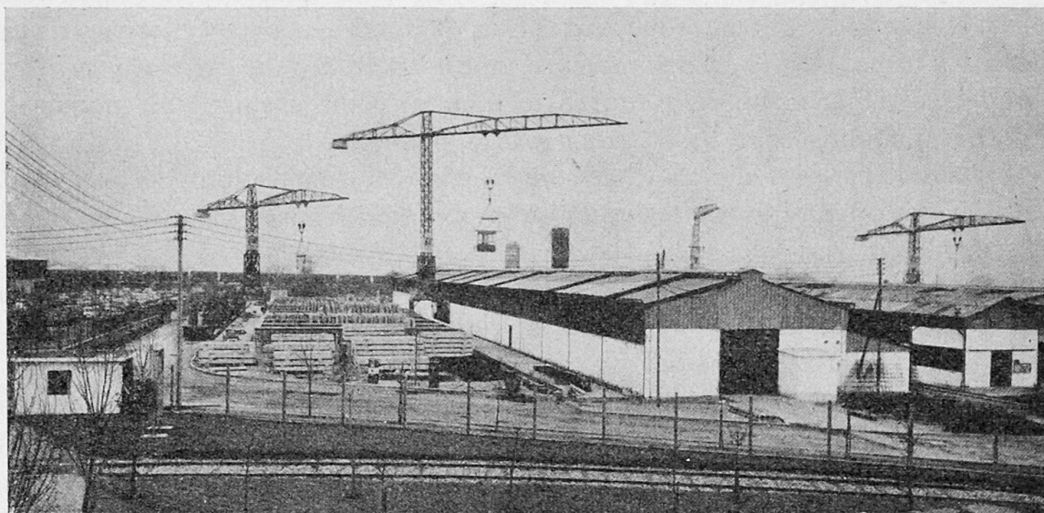
Fig. 5 - Usine de préfabrication à Villeneuve le Roi (1957) comportant des toits ouvrants et desservie par des grues (Balency).
