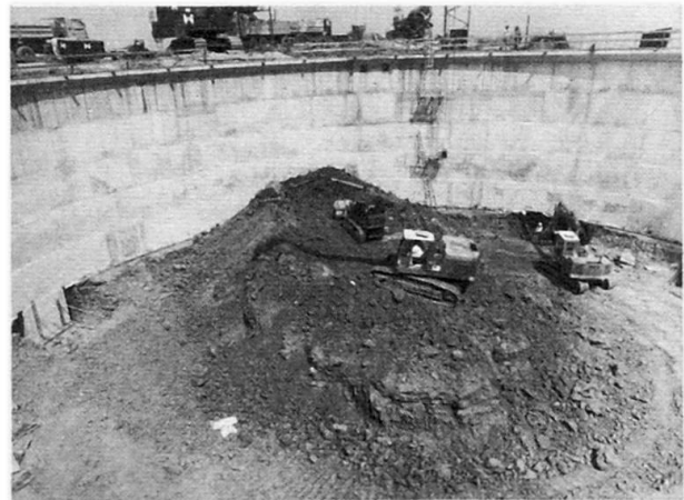
Bild 2: Aushub- und Betonierarbeiten in etwa 12 m Tiefe
