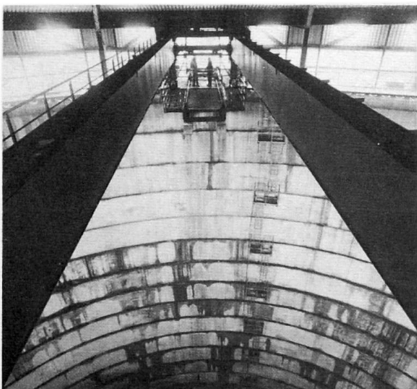
Bild 3: Blick in den fertigen Deponiebehälter mit Halbportalkran zum Ablassen der Müllcontainer in die Deponie
