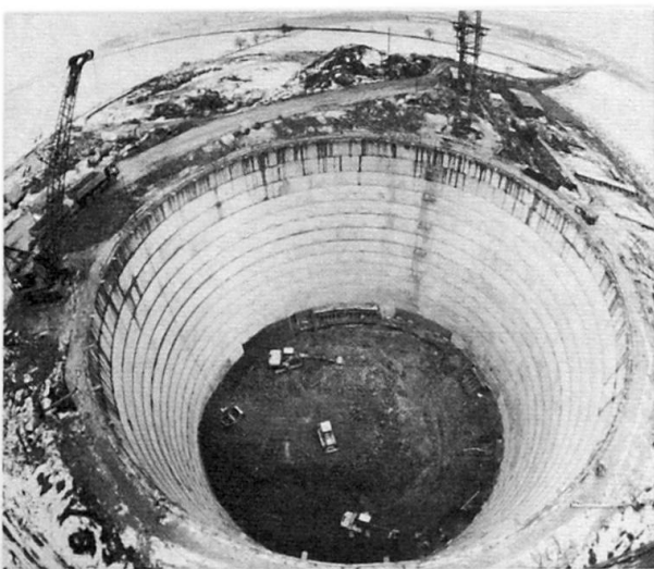
Bild 1: Bauzustand kurz vor dem Erreichen der endgültigen Tiefe
