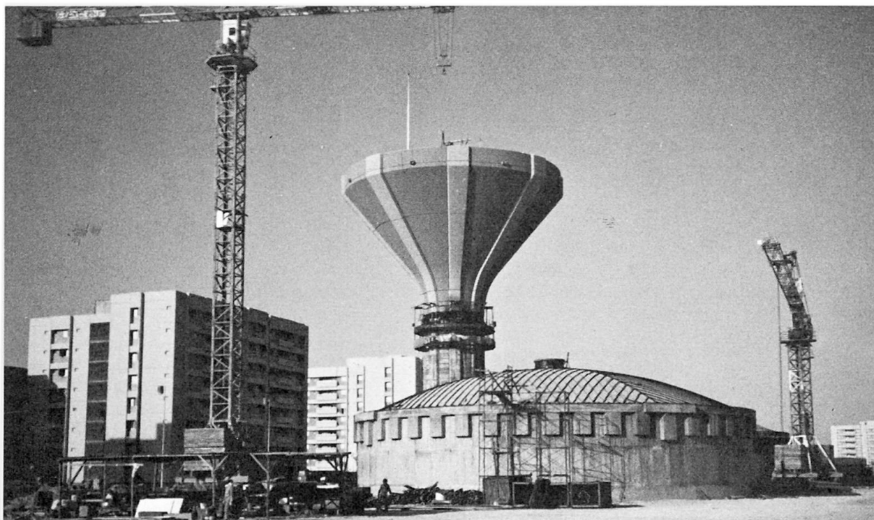
Vue d'ensemble en début de levage
