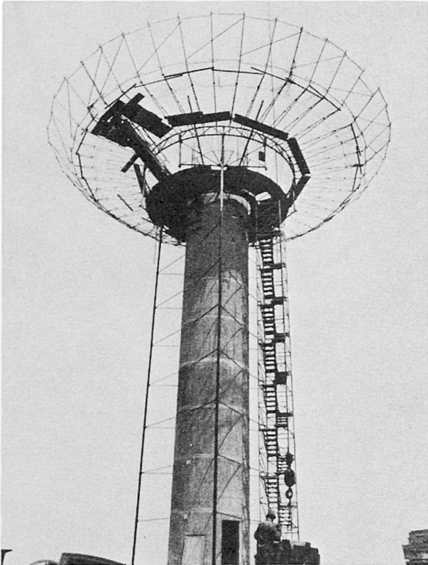
Bild 1 Schaft fertiggestellt Montage und Sicherheitsgerüst in Position gebracht
