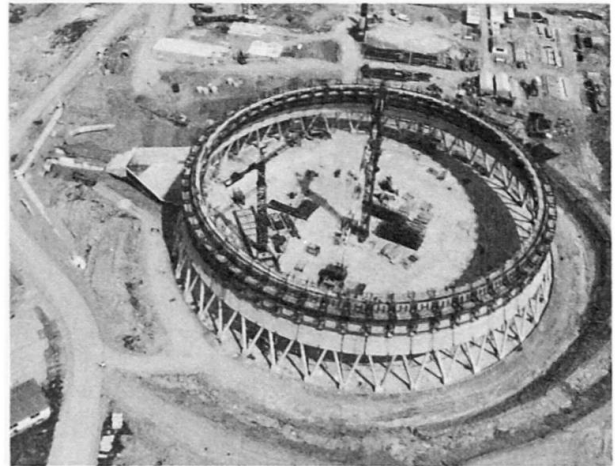
Coque en cours de construction
