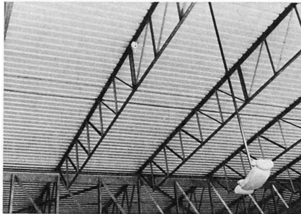
Fig. 6 Fermes à treillis de la piscine
