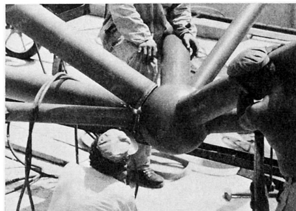
Fig. 4 Sphère de liaison entre béquille et traverse
