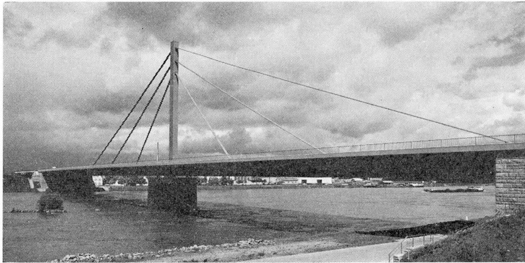
Fig. 37. Rheinbrücke Maxau, Mittelträgerbrücke (Entwurf L. Wintergerst).
