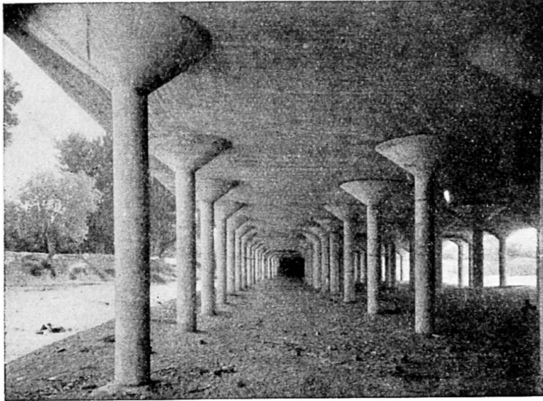
Fig. 1. Pont de Puerta de Hierro (Madrid). Travées d'approche de 120 mètres de longueur et de 17 mètres de largeur. Dalle de 30 cm d'épaisseur.
