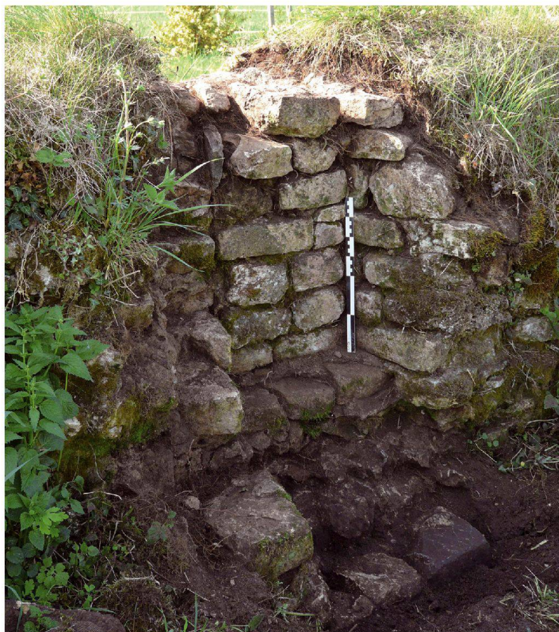
Fig. 16 2009.04. Mur des Sarrasins. Meurtrière basse avec son bouchon tardif.
