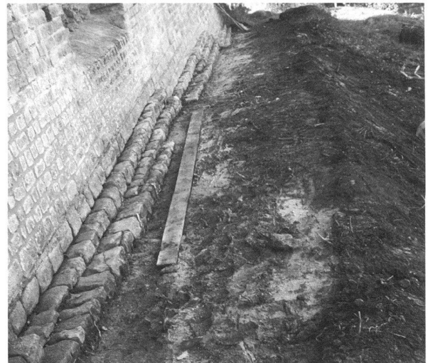
Fig. 10. Mur d'enceinte. Vue des travaux côté campagne, au nord de la Tornallaz. L'élévation du mur est rejointoyée, les assises en ressaut prêtes à l'être et la banquette de circulation bien débroussaillée pour faciliter l'entretien (photo MRA).
