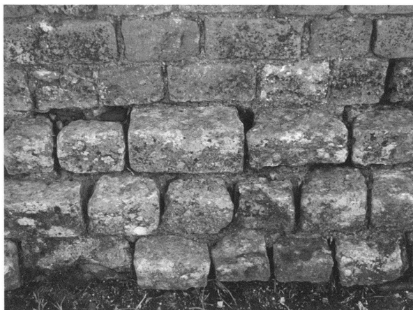
Fig. 9. Mur d'enceinte. Détail des assises de fondation en ressaut, dans leur état disloqué, avant restauration (photo MRA).
