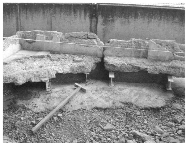
Fig. 3b. Les Thermes de Perruet. Détail des fondations modernes du bassin (photo MRA).
