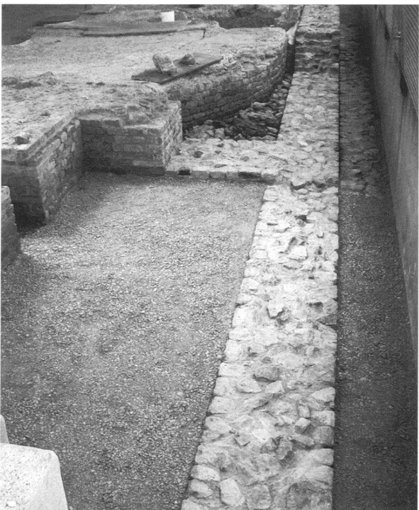
Fig. 5. Les Thermes de Perruet. Marquage au sol des murs détruits; au fond, l'angle du bassin remis en place et retenu par le mur de façade reconstruit. Le mortier de comblement de la lacune du fond du bassin n'est pas encore en place (photo MRA).
