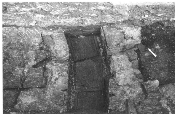
Fig. 19. Avenches/Insula 12. Canalisation maçonnée à fond de tegulae.
