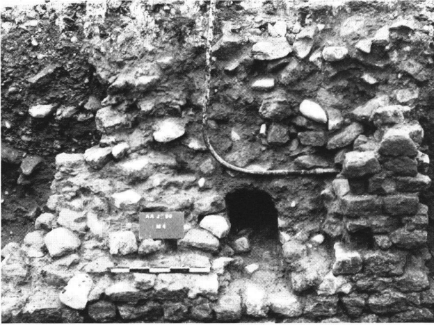
Fig. 15. Porte de Morat. Les soubassements du mur de front de la tour-porte (M4).
