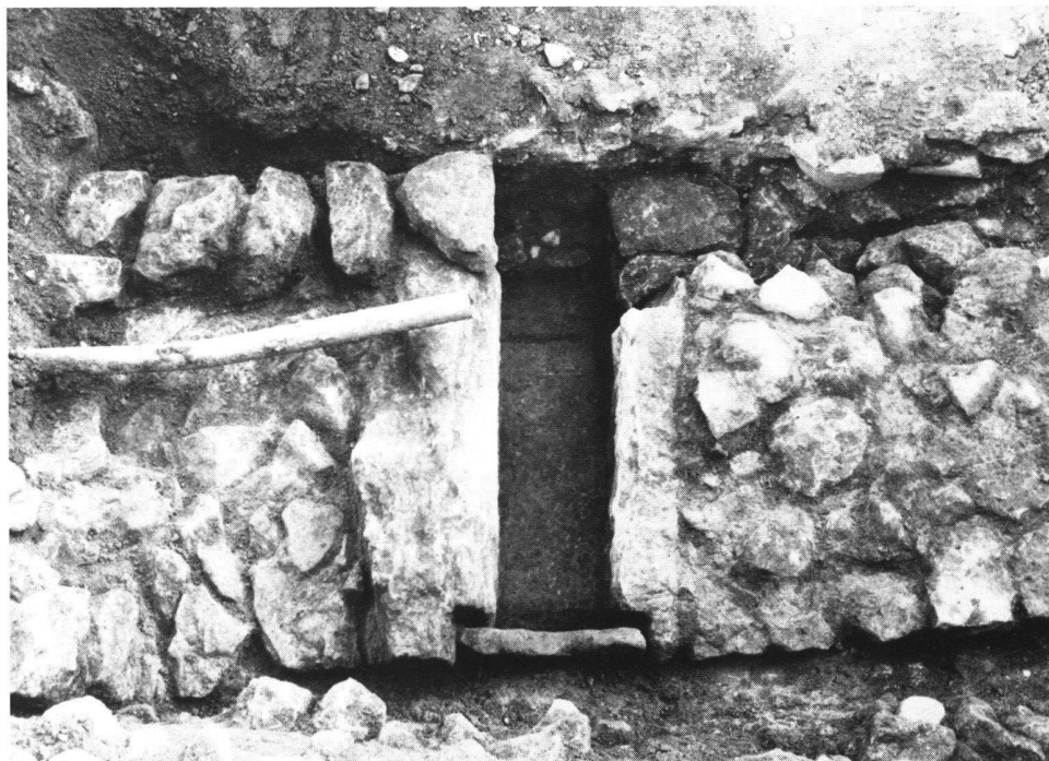
Fig. 25. Porte de Morat. Le conduit de vidange (St. 6) du mur de l'étang nord.
