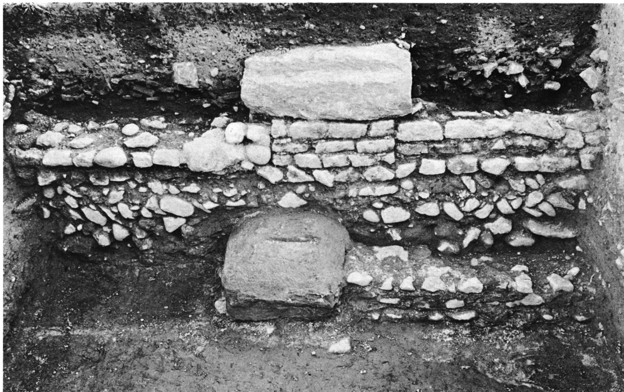
Fig. 1. Portiques de la troisième et quatrième étape de construction.
