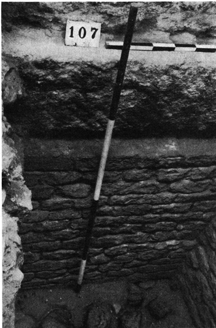
Fig. 2. — Fondement du pilier central dans le tepidarium avec grille de pieux en chêne.
