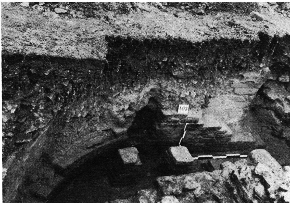
Fig. 9. — Caldarium , abside nord, avec revêtement mural en plaques d'argile, cheminée et, au premier plan, fondement de moellons pour labrum .
