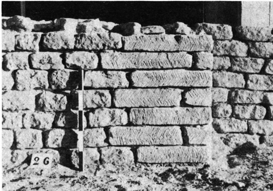
Fig. 1. — Maçonnerie de l'abside sud du frigidarium , avec des marques de ciseau.
