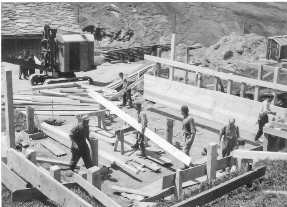
Unsere Wohnbaracke im Bau.
