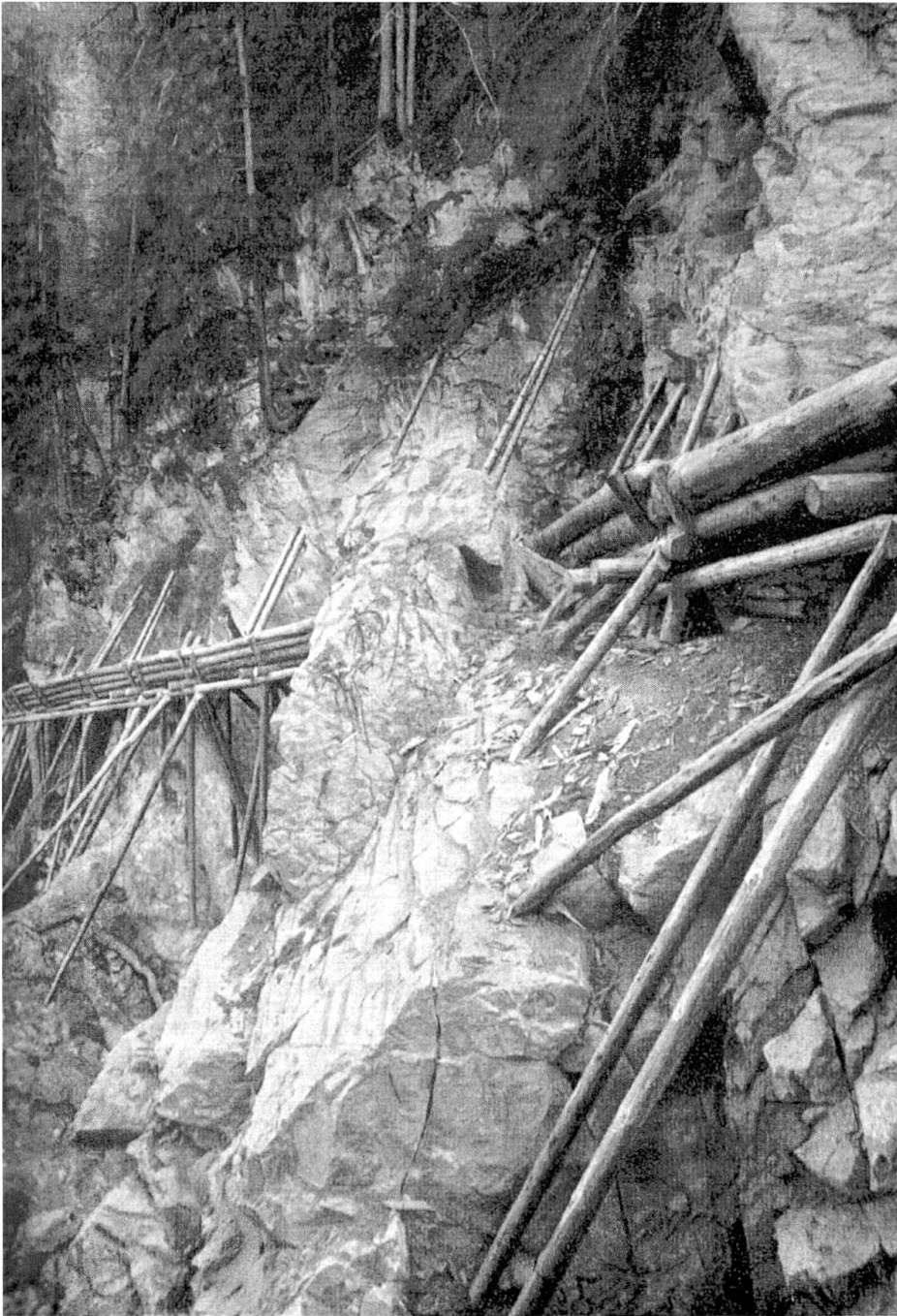
Reistkanal im Unterengadin. Damit wurde das Brennholz von den Abhängen hinunter in den Inn gebracht, von wo es häufig in die Salzpflanzen gelangte. (Bild: Forstinspektorat Graubünden, gedruckt in: BAVIER J.B., Schöner Wald in treuer Hand. Ein Buch über den Schweizerwald herausgegeben vom Schweizerischen Forstverein. Aarau 1949, S. 60.)
