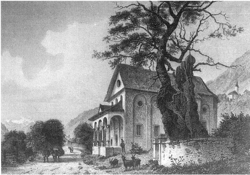
St. Annakapelle bei Truns Stahlstich von L. Rohbock
