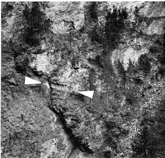
Bild 1: Auf der Teleaufnahme habe ich die fünf Löcher, mit je einem Pfeil markiert. Sie steigen genau wie das Wegniveau. Dieses erscheint hier durch nachträgliche natürliche Aufschüttung etwa 40cm höher als das zuletzt benutzte fahrbare Wegniveau und etwa 80cm höher als das nur 90cm breite römische Wegniveau. Die Löcher haben einen mittleren Abstand von 1,3m und sind ca. 12cm breit, 8cm hoch und 12cm tief. Sie befinden sich ca. 1,5 über dem letzten und ca. 1,9m über dem römischen Wegniveau. Das südliche Loch liegt 20cm höher und gehörte wahrscheinlich zur Haltevorrichtung zum Steg über die folgende Runse.
