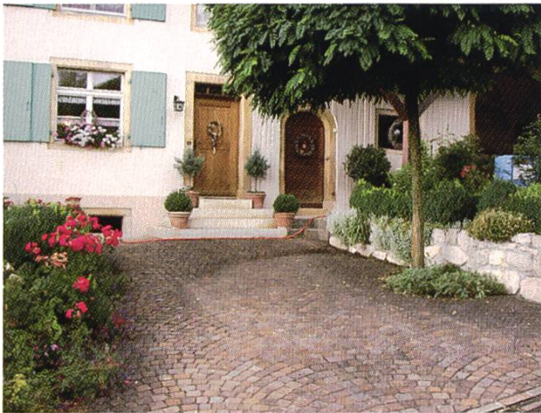
Abb. 4.10: Vorgartensanierung an der Mittleren Gasse in Wenslingen.
