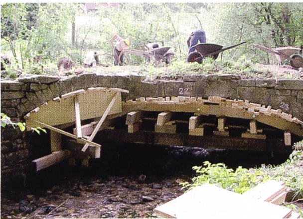
Abb. 5.7: Ein Gerüst stützt von Arbeitsbeginn an den Brückenbogen.
