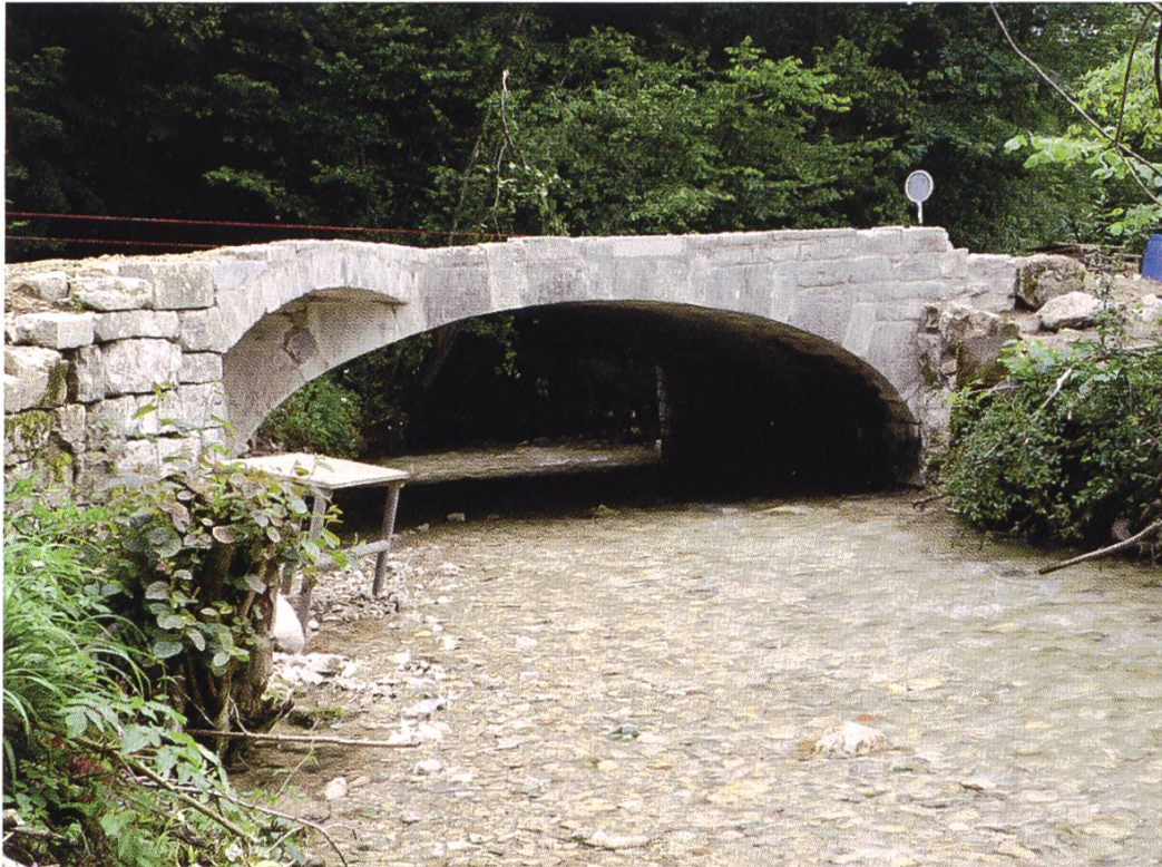
Abb. 5.12: Die Bütschenbrücke nach der Sanierung.
