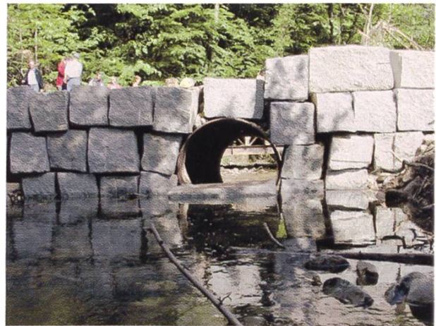
Abb. 5.5: Der Schutzdamm mit dem Durchlass.
