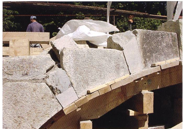
Abb. 5.8: Die bergseitige Bogenaussenseite nach dem Wiederaufbau. Die drei im Bild sichtbaren Läufersteine mussten ersetzt werden, da die alten Steine zerdrückt waren.
