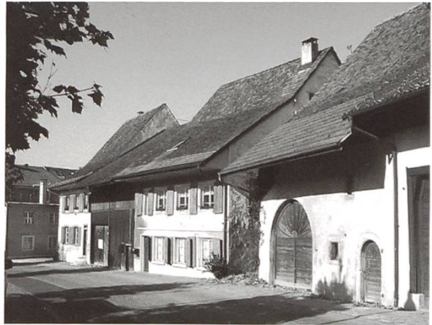
Abb. 6.4: Känerkinderstrasse 5–7 in Diegten: verdichtetes Bauen wie in Waldenburg.
