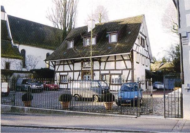
Abb. 4.9: Vorplatzgestaltung an der Schönenbuchstrasse 3 in Allschwil.
