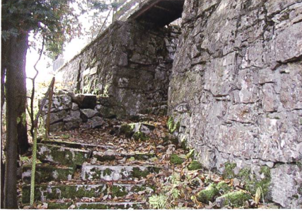
Abb. 7.4: Treppe zu den Rasenterrassen über Stützmauern. (Foto: Johanna Strübin, November 2007)
