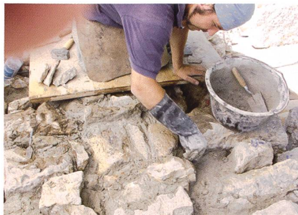
Abb. 5.11: Ausfugen und Auffüllen mit kleinen Steinen.
