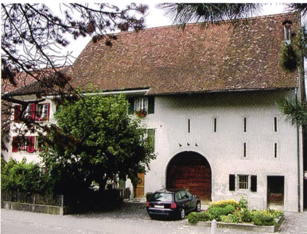
Abb. 4.11: Platzsanierung vor Ökonomiegebäude an der Hauptstrasse in Pratteln.
