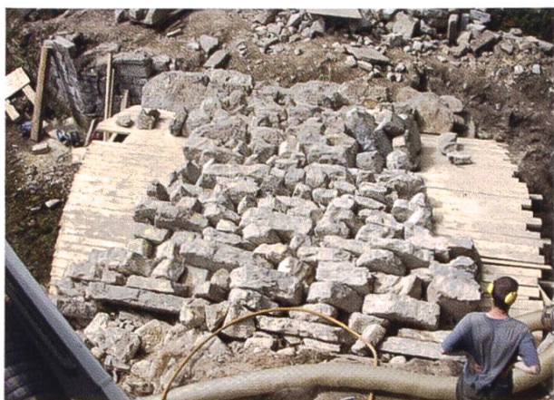
Abb. 5.10: Die Steine werden auf dem Leergerüst neu positioniert.
