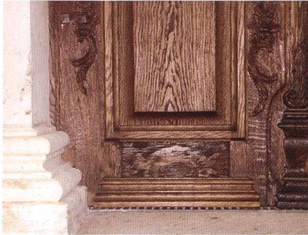
Abb. 1.1: Arlesheim, Domkirche Hauptportal: Die Spuren des originalen Rahmendekors sind wieder sichtbar.
