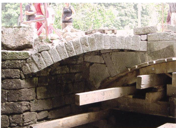
Abb. 5.9: Der talseitige Seitenbogen nach dem Wiederaufbau.
