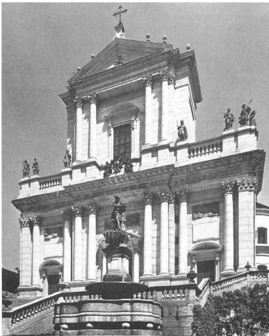
St. Ursen-Kathedrale. Hauptfassade.
