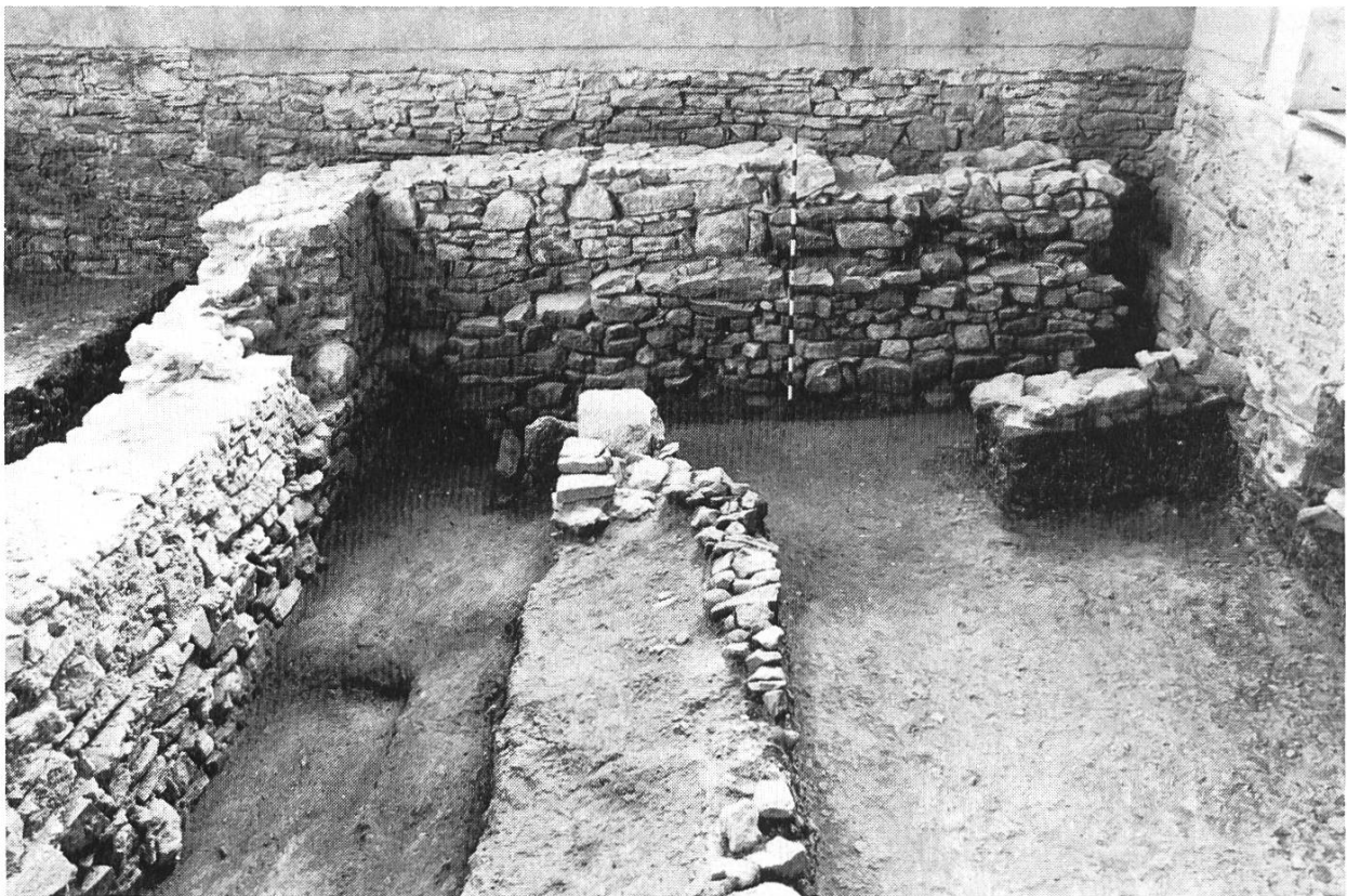
Bild 10. Baubefund im Bereich des Chores. Reste der gotischen, romanischen und frühmittelalterlichen Rechteckchöre. Vergleiche die Grundrisspläne!
