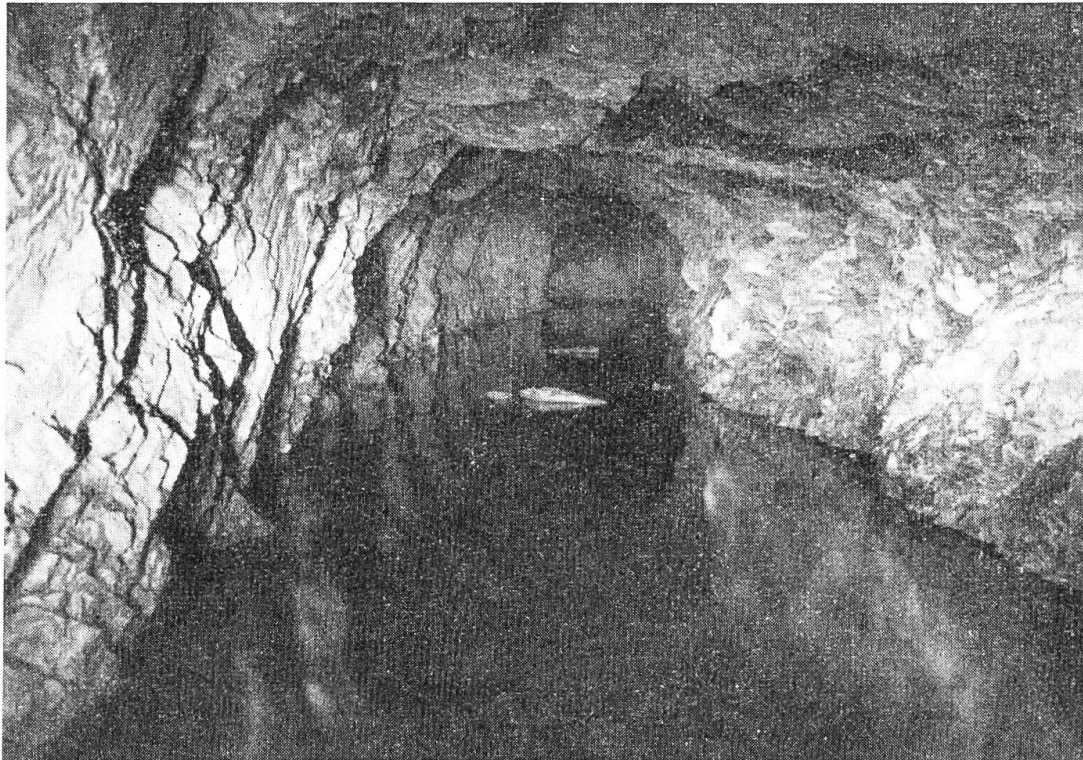
Wasserfallentunnel, nördlicher Vortunnel. Quellaustritt im hintern Teil des Stollens; diese Quelle wird heute noch verwendet. Wasserstand 60 cm.
