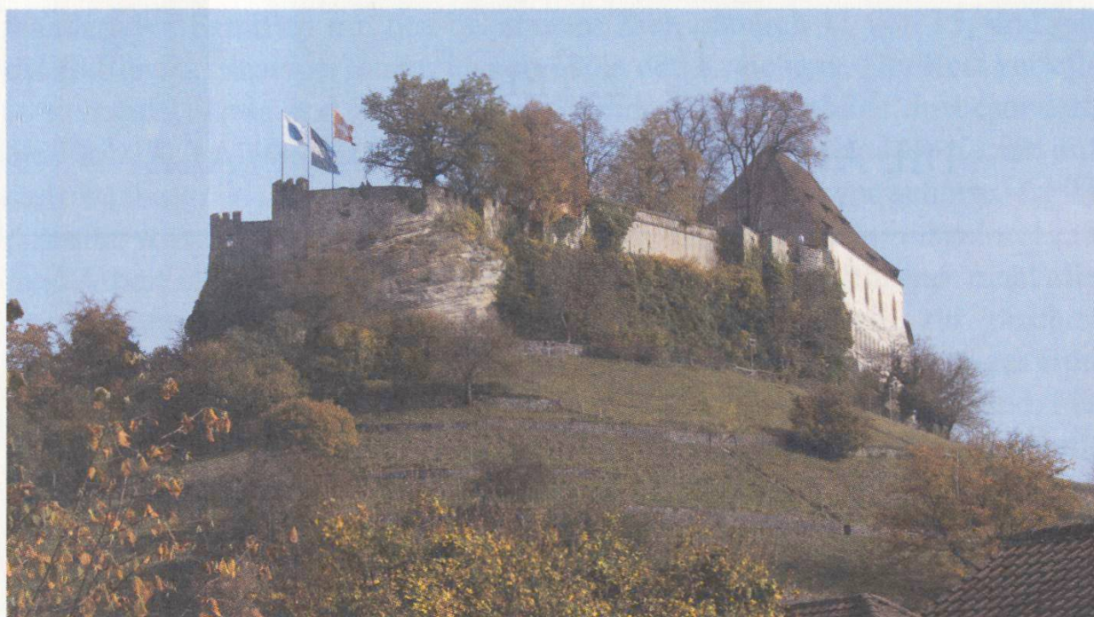
Das Schloss Lenzburg, ehemals Sitz eines bernischen Landvogts, krönt einen markanten Hügel. Der im Kern auf das 12. Jahrhundert zurückgehende Bau weist Festungscharakter auf. Das Bild zeigt nur einen Teil der zahlreiche Gebäude umfassenden Anlage.
