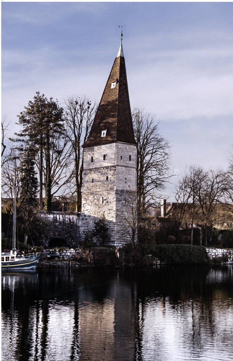
Abb. 1 Solothurn, Krummturm, Krummturmstrasse 4. Ansicht nach der Restaurierung 2020.
