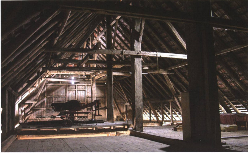
Abb. 5 Dachstock mit partiell erhaltener Hochstudkonstruktion. Leitmotiv des Architekten war, diese spezielle Atmosphäre mitzunehmen und die Wohnungen als «Boxen» im grossen leerstehenden Volumen zu stapeln.
