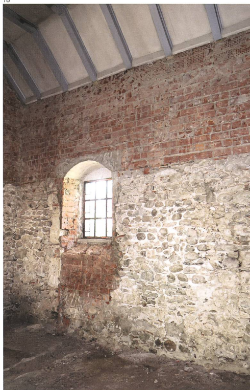
Abb. 16–20 Innenansichten der Mauern nach der Abnahme des Zementverputzes. Man erkennt verschiedene Mauerwerke, zugemauerte Öffnungen und Baunähte. Gut ersichtlich sind die in den 1930er/1940er Jahren erstellten Mauerwerks- erhöhungen in Backstein.
