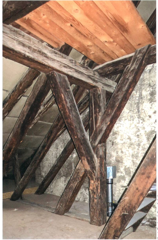
Kant. Denkmalpflege Solothurn.
