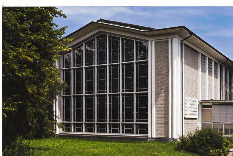
Kant. Denkmalpflege Solothurn.
