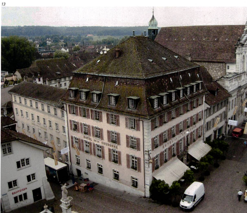
Abb. 13 Die «Krone» vor dem Umbau 2015–2017. Vorne der markan- te barocke Eckbau, südlich angefügt der in mehreren Eta- ppen aufgestockte Annex- trakt. Foto 2014.
