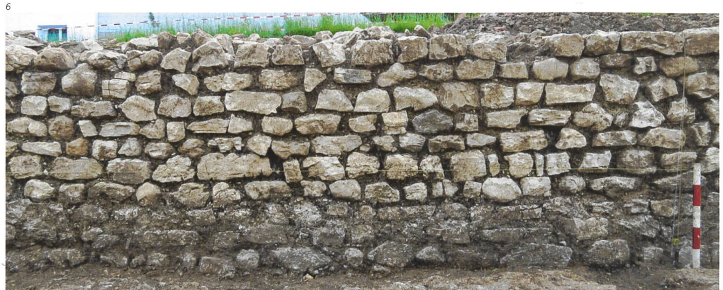
Abb. 7 Umgestürztes Mauerstück M3 mit drei Ziegelausgleichslagen.
