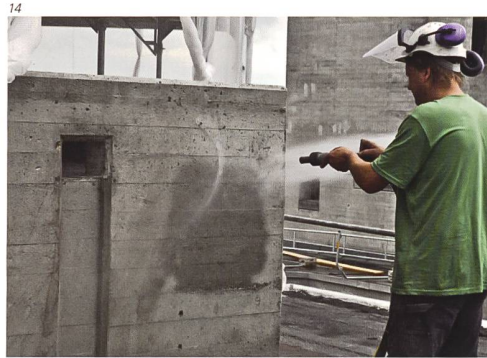
Kant. Denkmalpflege, Benno Münter.
