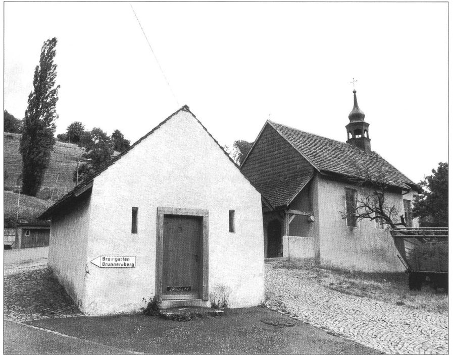
Laupersdorf/Höngen, Kapelle und Feuerwehrmagazin nach der Dachsanierung.
