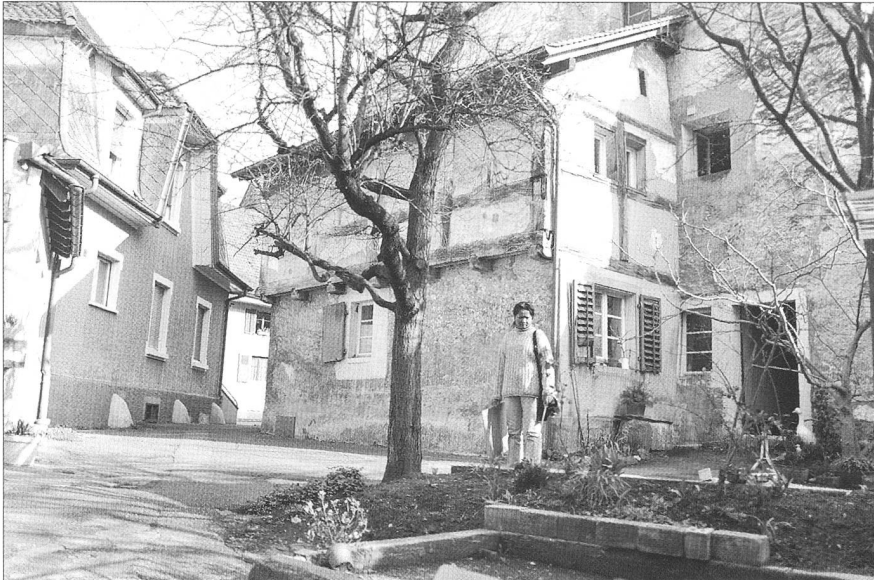
Abb. 6 Der Anbau auf der Nordseite ist ein Ständerbau aus Eichenholz, er wurde um 1610/20 errichtet.
