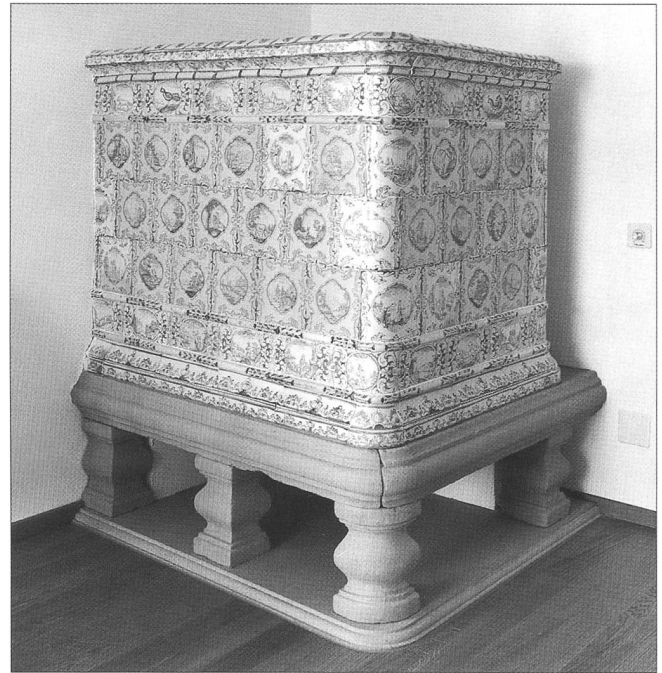
Abb. 4 Erdgeschoss, Sitzungszimmer. Der neu aufgestellte Kachelofen, der ursprünglich in der Stube im 1. OG stand.
