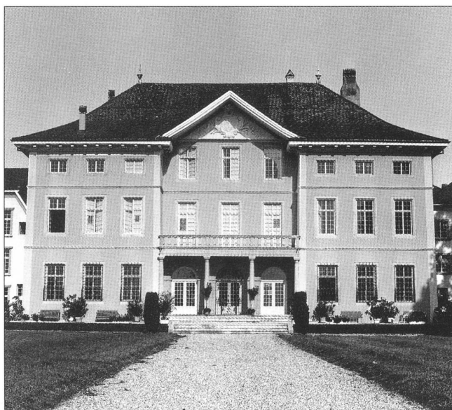
Abb. 3 ...und nach der Renovation von 2002.
