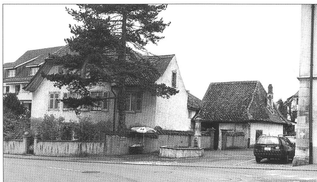
Abb. 1 Dornach, altes Pfarrhaus vor der Restaurierung, 1998...
