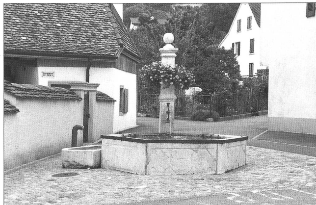
Abb. 2 ...und nach der Restaurierung von 2002.
