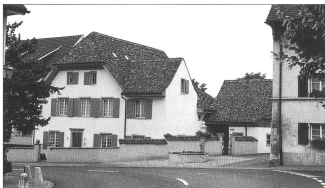
Abb. 2 ...und nach der Restaurierung von 2000/2001.
