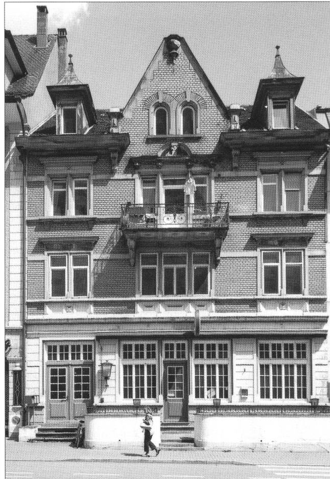
Abb. 1 Olten, «Salmen» Hauptfassade nach der Ringstrasse.
