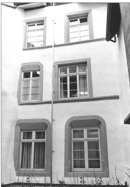
Abb. 2 ...und nach der Restaurierung von 2001.
