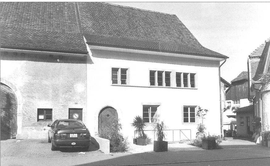
Abb. 2 ...und nach der Renovation, 2002.
