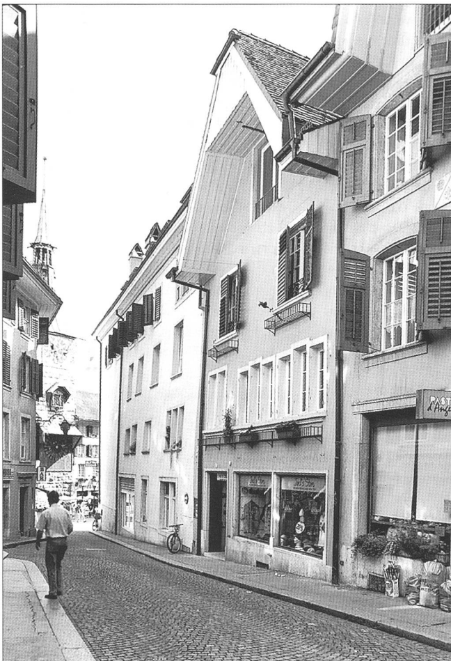
Abb. 1 Solothurn, Barfüssergasse 1, Ansicht des Hauses im heutigen Zustand.
