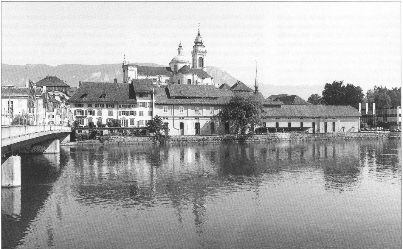
Abb. 1 Solothurn, der ehemalige Schlachthauskomplex nach den Umbauten von 2002.
