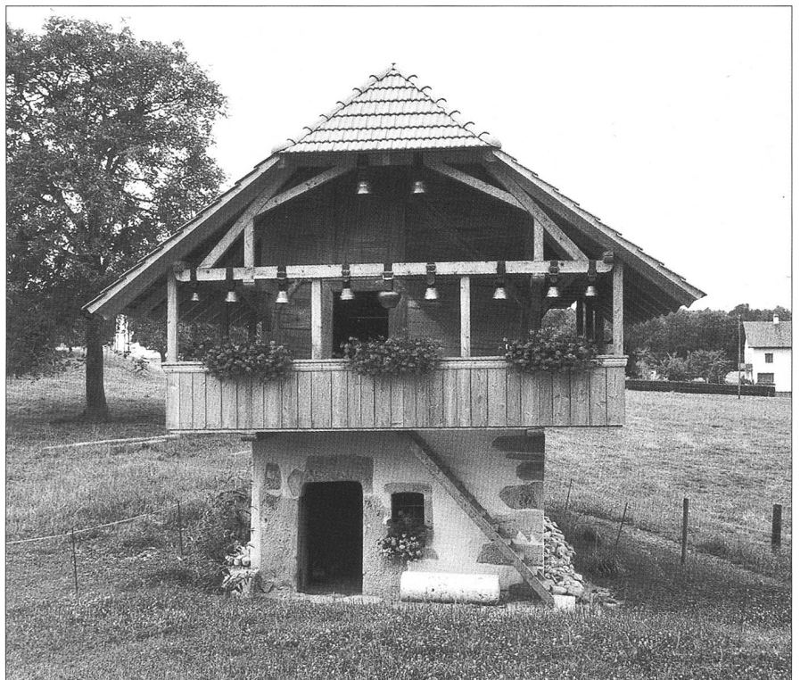
Lütterswil/Gächliwil, Speicher Andres nach der Instandstellung.
