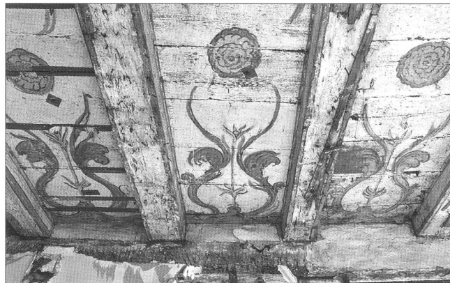
Abb. 5 Erdgeschoss, Sitzungszimmer. Bemalte Balkendecke, Fundzustand (vgl. auch Titelbild).
