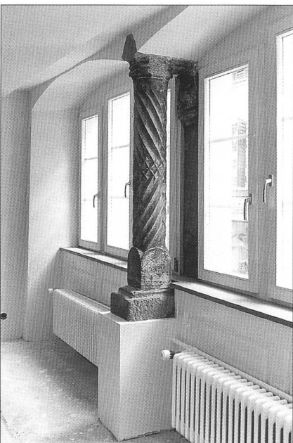
Abb. 5 Fenstersäule in der Stube im 1. Obergeschoss nach der Freilegung und Restaurierung.
