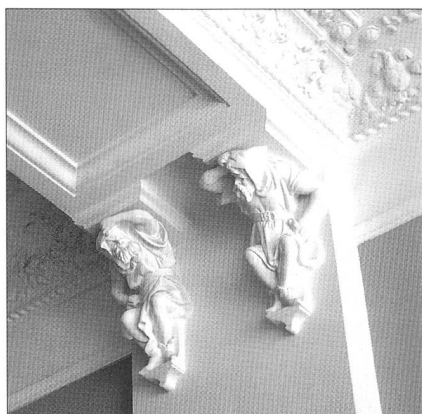
Abb. 4 Detail Konsolle am Unterzug in der Raummitte.
