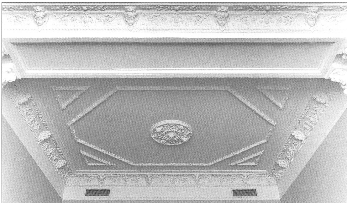
Abb. 3 ...und nach der Restaurierung, 2003.
