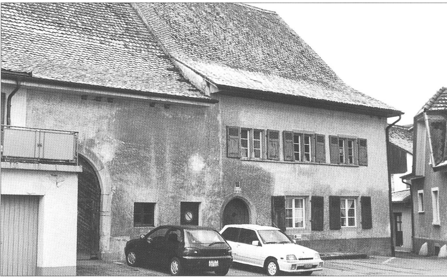
Abb. 1 Dornach, Hauptstrasse 30/32, Zustand 2000...
