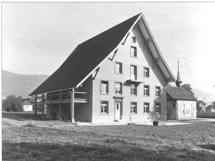
Abb. 4 ...und nach der Restaurierung von 2002/03.
