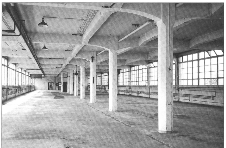
Abb. 2 Fabrikationshalle der Schuhfabrik Hug, 2002.
